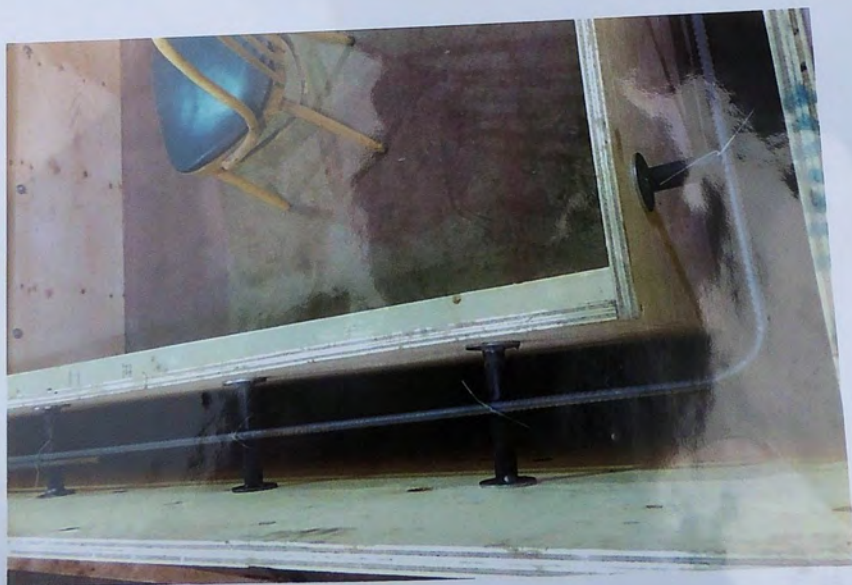
Fabrication et installation des tiges d'acier dans la base qui servira à couler le ciment. Installation d'un ancrage rond pour la future croix.
