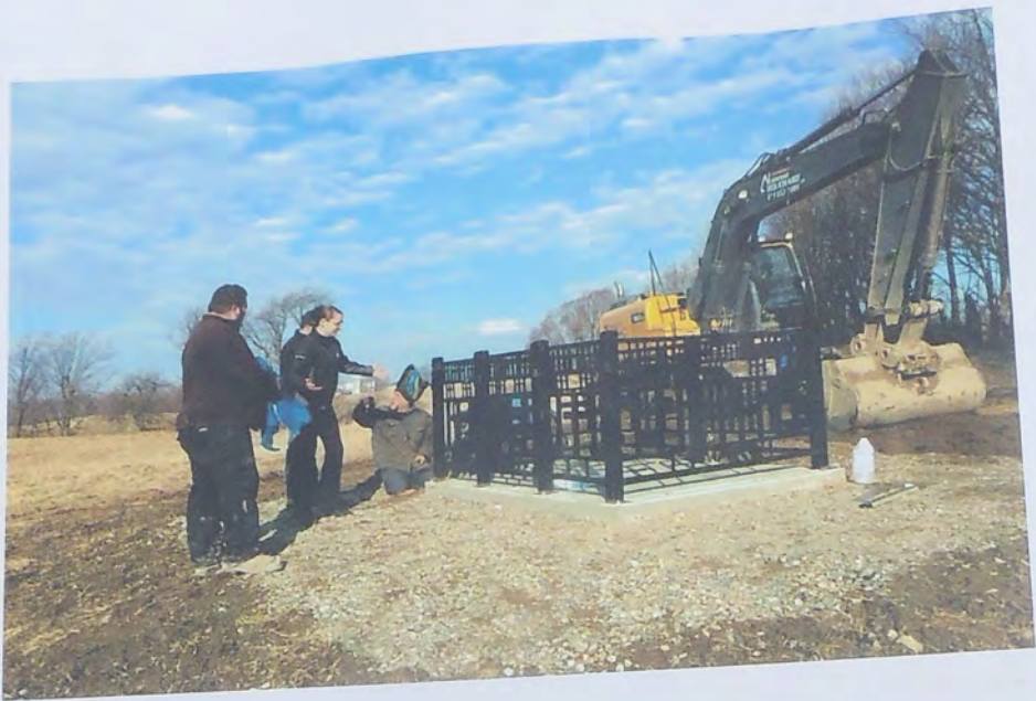
Installation de la clôture au coin de la route 251 et chemin Simard. Cette installation est bonne pour plusieurs années.
